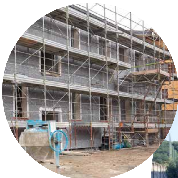
Sopra a sinistra: Cantiere edile ALL, Vimodrone
