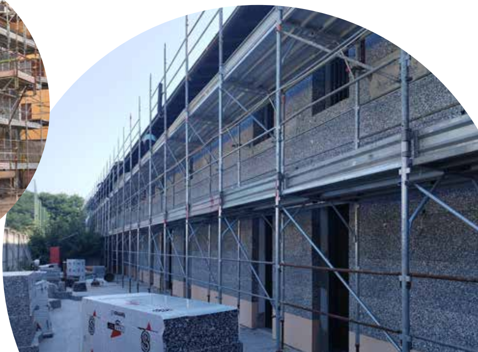
A destra: Cantiere edile Casa del Giovane, Pavia
